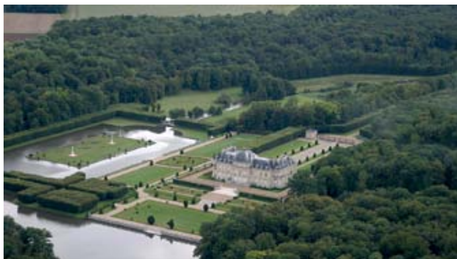
LE PARTERRE DE L'ÎLE EST DEvenu UN « TAPIS VERT » AUJOURD'HUI. IL NE RESTE QUE LE « PARTERRE DE LA LÉGIon D'HONNEUR » EN CONTREBAS DU CHÂTEAU...
